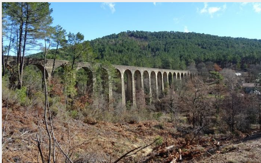
Le viaduc de Doulovy (© J.F.Raulet)
