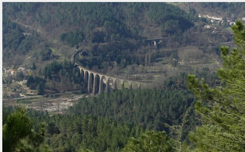
Vue sur le viaduc (Nathalie Thomas)
